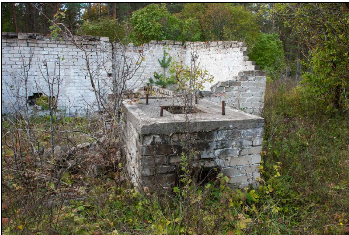
Foto 10 (929). Levalõpme (Liiva) raketibaas Muhus. Katlamaja korstna alus. Foto Mart Mõniste 28.09.2013.
